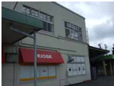
釜石湾漁協仮事務所 釜石駅の2階を借りている。
